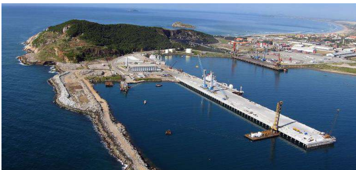
Figura 2 - Complexo portuário de Imbituba Fonte: Portal Ndmais, 2020.
