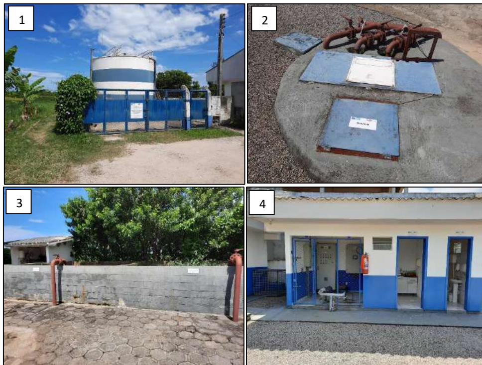
Foto 1 - Estação de tratamento de efluentes domiciliares - Imbituba/SC
